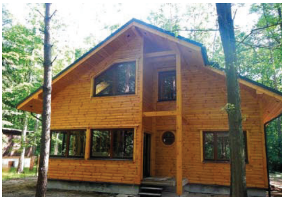
Badany budynek jest mocno zastójny, ma wysokość 7,3 m i kubaturę 616 m 3 . Pole obudowy budynku wynosi 477 m 2 , a pole powierzchni podłogi – 123 m 2 .
